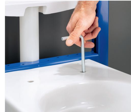
↑ Die WC-Wandbefestigung EFF3 wird von oben über die Aussparungen zur Sitzbefestigung per Sechskantschlüssel festgezogen.
