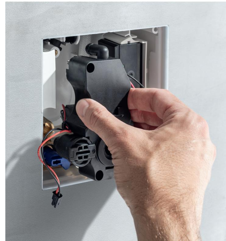
↑ Unterputzfunktionsbox in verschiedenen Varianten, z. B. mit Thermostat und Mischer
