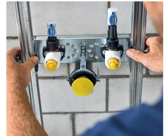
↑ Schnelle und sichere Fixierung und einfache Höhenanpassung der Montageelemente ohne Werkzeug.
